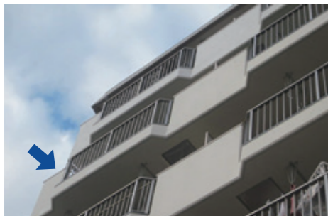
地盤の制約からベランダ側のアウトフレーム工法が難しい状況を、ベランダを取り払って建物本体の柱と梁を増し打ちして補強する方法で解決(中段)。ベランダも取り付け直し(下段矢印参照)
