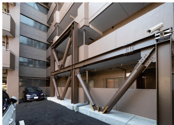
Kマンションの耐震補強。廊下や天井にも補強を施し、ブレースを支える支柱は、建物本体と同等の地中深くまで掘り下げて設置。耐震ブレースが、第2の躯体として機能する
