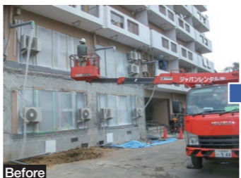
Iマンションでは、建物表側(1Fバルコニー内部)をアウトフレーム工法で、裏側をブレース工法で補強。単なる構造計算だけでなく、将来にわたる生活と建物価値を損ねない工事を提案するには、センスも必要だ
