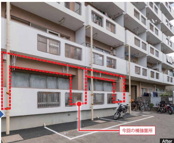
Kマンションの耐震補強。廊下や天井にも補強を施し、ブレースを支える支柱は、建物本体と同等の地中深くまで掘り下げて設置。耐震ブレースが、第2の躯体として機能する
