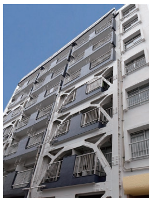
Bマンション(東京都西東京市)の耐震補強工事
