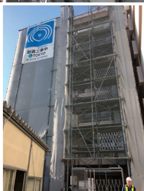
Eマンション(東京都江戸川区)の耐震補強工事
