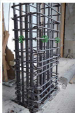
KSマンション(東京都江戸川区)の耐震補強工事では、耐震壁を柱型にして、サッシ開口スペースを確保し、居住環境の向上に努めた
