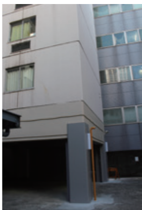
SQビル(東京都新宿区)柱鋼板巻き補強
