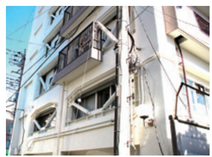
SRマンション(武蔵野市)/鉄骨ブレース接着工法
