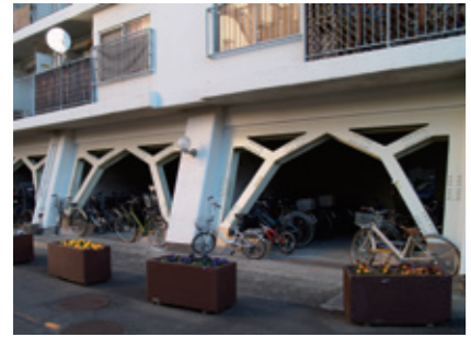
F住宅(江東区)/鉄骨ブレース在来工法
